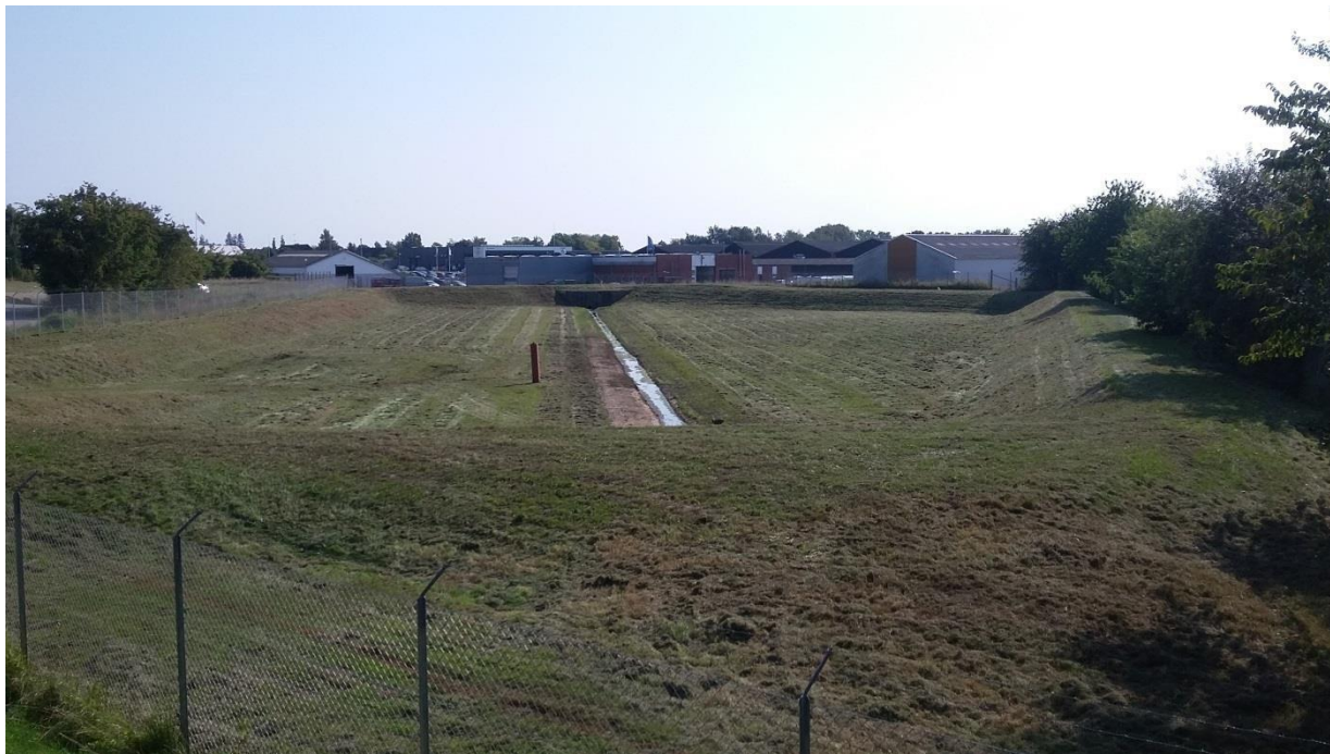
Figur 2-16 Forsinkelsesbassin i indsatsområde H2. Billedet er taget med retning mod syd.
