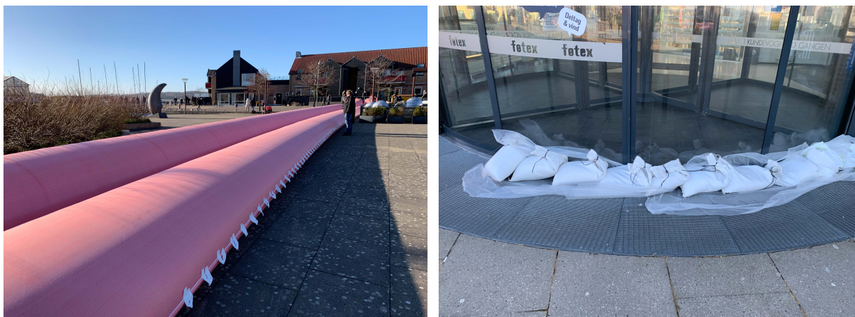
Figur 1-5 Anvendelse af sandsække og oppustelig dæmning, Kilde: Klavs Bundgaard, NIRAS
